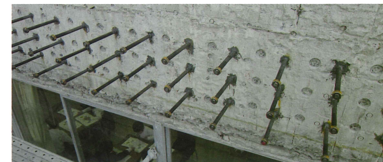
ブラストキー工法による施工事例
